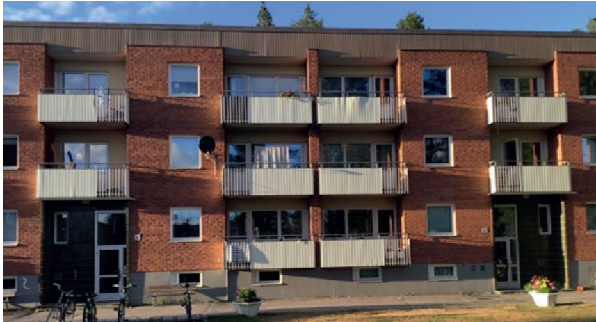
Figur 4. Byggnaden närmast Domängatan. Bild: Tomas Örn
