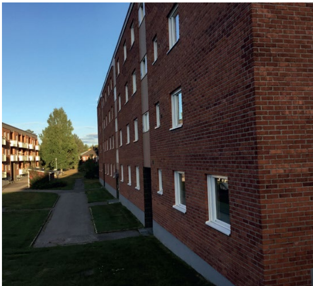
Figur 5. Baksidan av byggnaden närmast Domängatan. Bild: Tomas Örn
