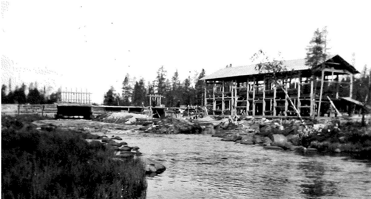
'Gammelsågen', Fjällbonäs såghuset under uppförande.
