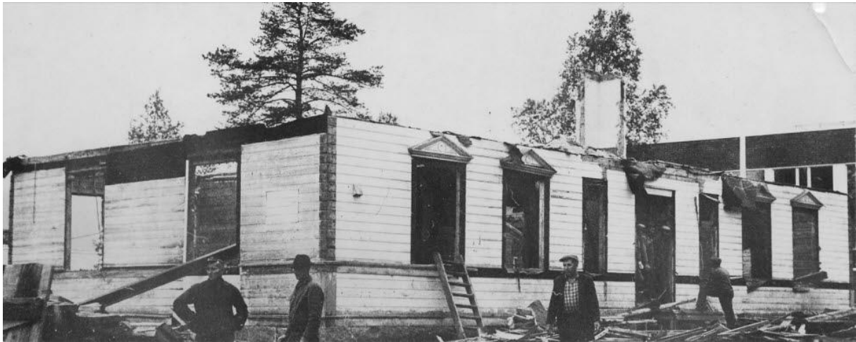
Gamla byggnaden Fridhem rivs. Nysa skolan skymtar i bakgrunden.
