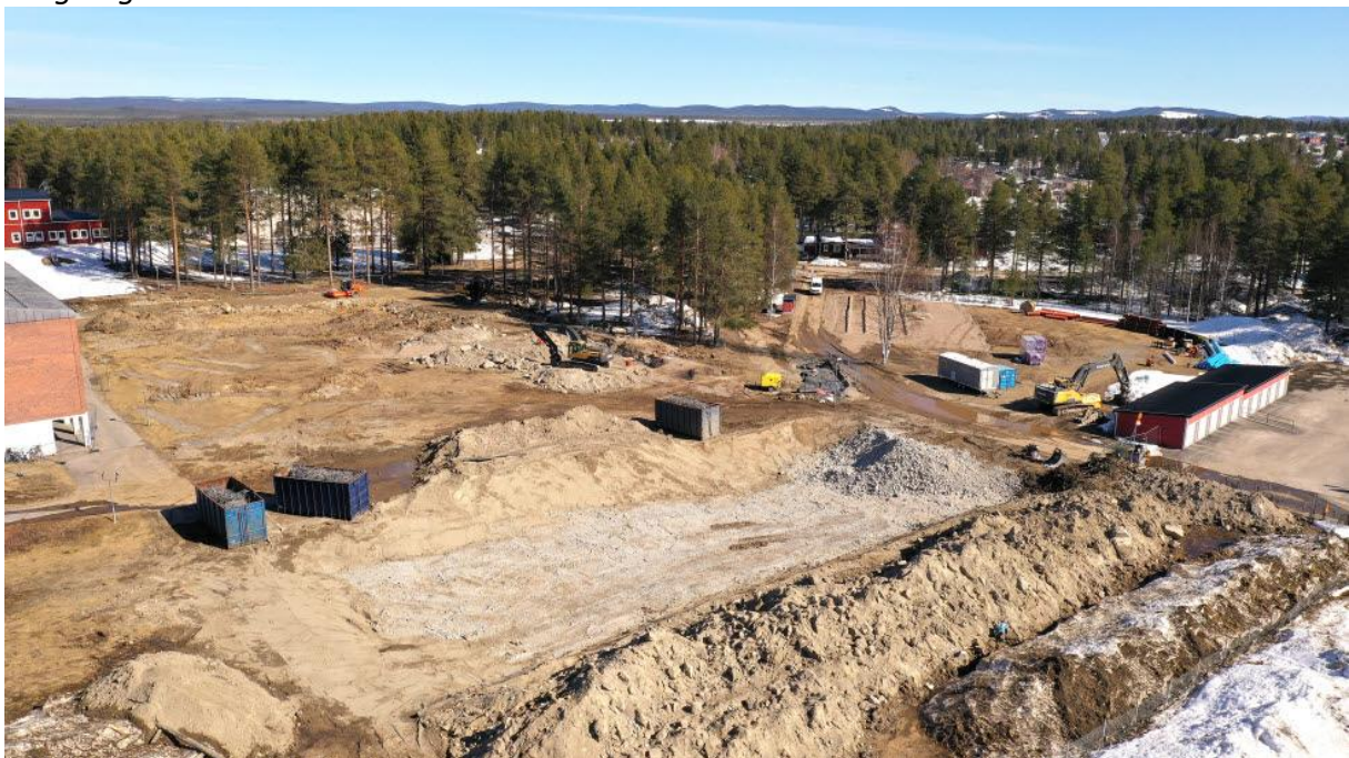
2024-04-21. En ny sim- och sporthall byggs bredvid 1960-talets anläggning. När den står klar, rivs gamla Centrumbadet. Foto Kent Norberg, Arvidsjaurs kommun.
