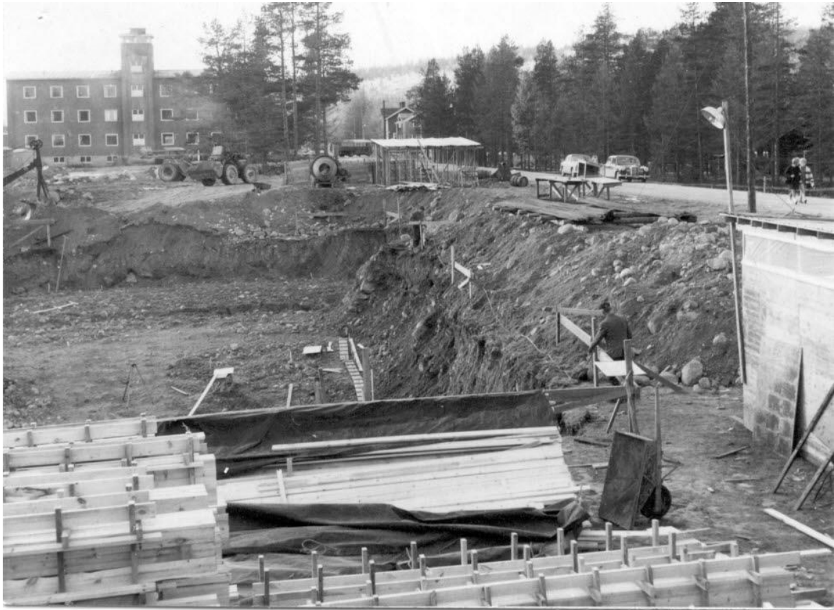
Badhuset under uppbyggnad 1961, stor glädje för Arvidsjaurbor att få ett badhus! Invigningen skedde 1962. Foto Norran.
