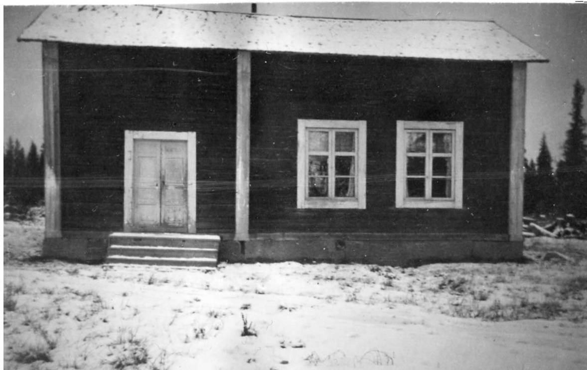
Skolan i Västlunda byggdes som bostadshus men användes som skola. Bakom de två fönsterna fanns skolsalen och till vänster i en liten kammare bodde lärarinnan Ester Bodin från Härnösand. Skolan lades ner 1928.
