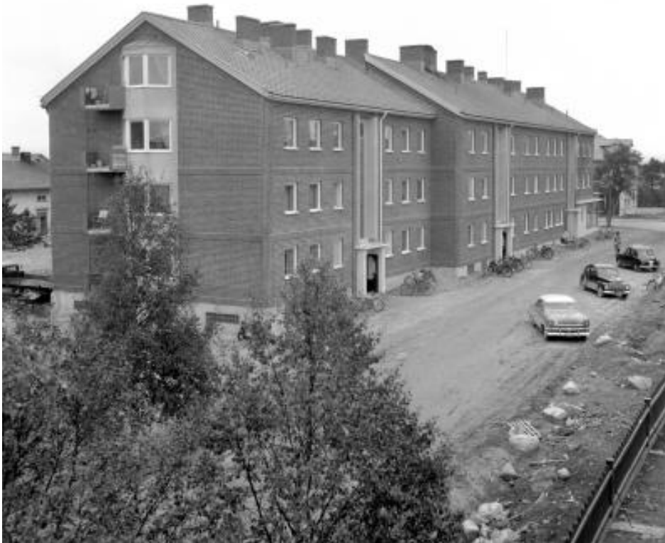
Nybyggda Centrumhuset på Västra Skolgatan inflyttningsklart.
