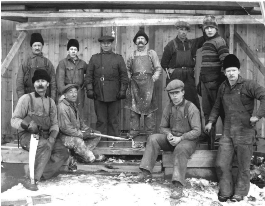
Byggnadsarbetare. Hugo Stenlunds hus byggs i korsningen Skomakargatan-Östra Skolgatan vid Cirkustorget. Slutet av 1930-tal. Sittande två från vänster: Pip Artur Södermark , 1890–1969. (Se andra bilder).
