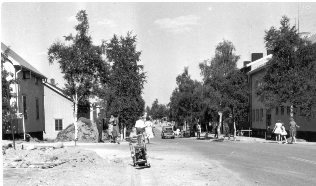
Stor gatuombyggnad i slutet av 1950-talet. Trottoarer längs Stationsgatan under byggnad. Till vänster: Steinvalls och gamla Föreningshuset på kvarteret Lommen. Till höger: Televerket (Stalo) och Tempohuset (Tant Sveas Kafé) på kvarteret Bofinken.
