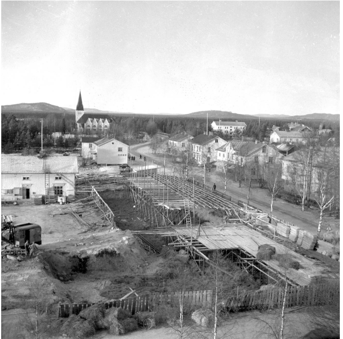
Centrumhuset Storgatan, och senare på Västra Skolgatan, under uppbyggnad tidigt 1950-tal.
