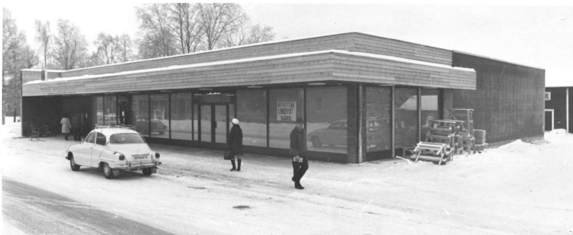
Nybyggd affärslokal där J A Wisings hus och Järnaffären tidigare funnits på Storgatan 17–19. Bild från 1971. Foto: Norran.
