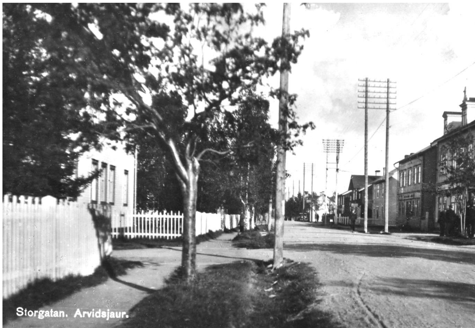
Storgatan, 1920-tal. Till vänster: Herman Johanssons Bokhandel. Till höger: Närmast Sjöbergs klädbutik.
