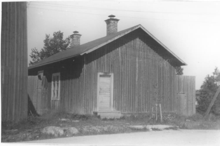
Bild av gamla arrestlokalen i Arvidsjaur i hörnet av Västra Skolgatan och Nygatan tagen år 1931
