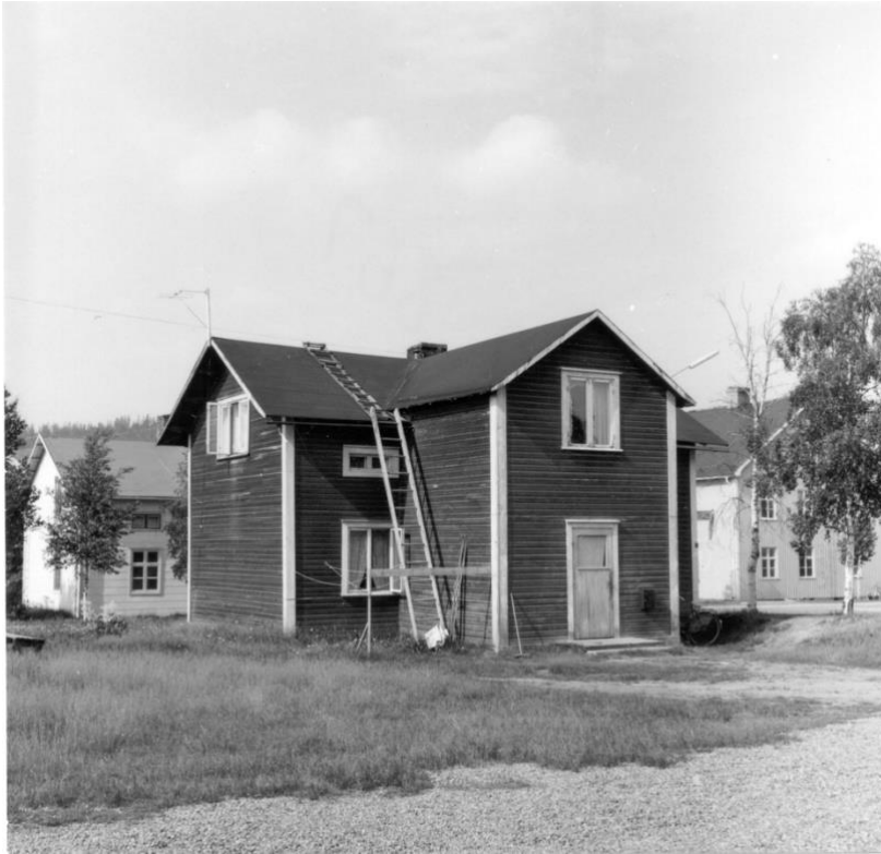
Jonas Degermarks hus, Stationsgatan 10, år 1964. Flyttat till sin nuvarande plats på kvarteret Korpen 9, från kvarteret Orren 1. Tros ha varit Lindqvists första handelshus.
