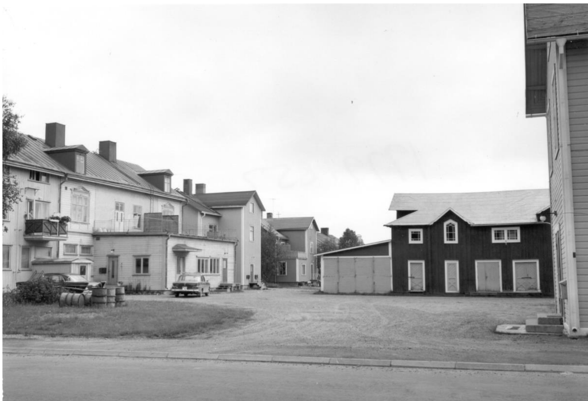
Innergården till Sjöbergs, Sparbanken m fl byggnader. 1964 på kvarteret Lommen. I mitten det hus vi idag kallar "Humlan".
