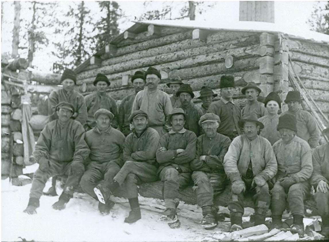
Skogsarbetare vid timmerkoja i trakten av Fiskträsk. Ca 1927.
