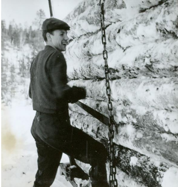
Tv: Lastbilsföraren Bert-Olov Söderberg säkrar lasten med järnkätting och björnbindsle inför transporten till sågen i Fjällbonäs. Foto Norran 1961.
