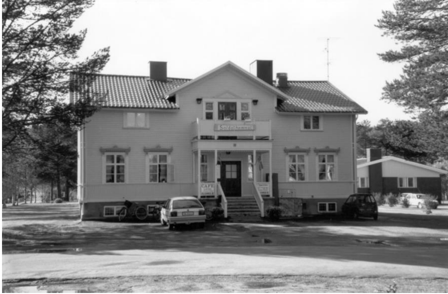
Det nya Församlingshemmet invigdes 1975, och 1981 renoverades gamla Församlingshemmet till Soldathem och fick namnet Marklundsgården. Källa: Lennart Öhman.
