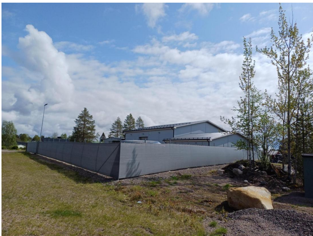
Figur 4. Befintlig byggnad på Arvidsjaur 6:13
