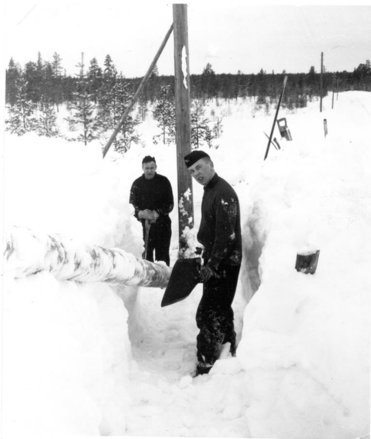
Tv: Eugen och Sören Modig, telearbete mellan Moskosel och Ljusträsk. Ca 1957. Telearbetarna Eugen Modig och sonen Sören Modig kämpar med snömassorna för att sätta upp de stolpar som fraktats dit på sommaren och legat begravda under två meter snö.
