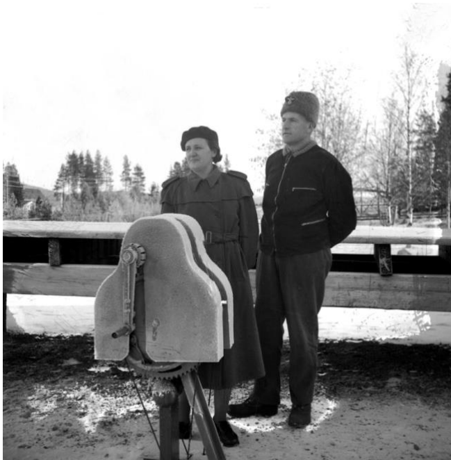
SJ:s platsvakt Ragnar Holmqvist och Gunvor. Apparaten på bilden är ett handdrivet linspel för bomfällning vid en näraliggande vägövergång. (Källa: Jan Sandgren.)
