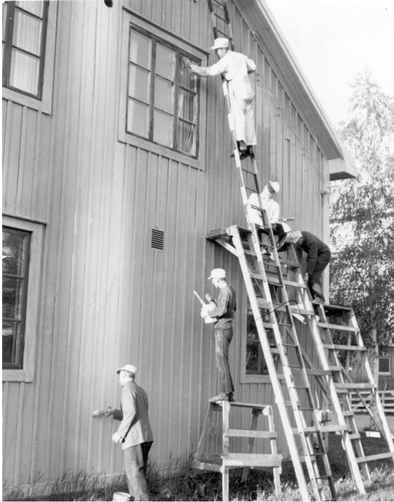
Gamla Prästgården renoveras år 1972. Lions och Rotary hjälppte till med reparations- och målningsarbetet när Gamla Prästgården började användas som museum. Foto Norran.
