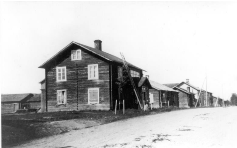
Bondstaden med kyrkstugor på Nygatan, 1950-tal Närmast: Fjällbonäsgården i Bondstaden. Kyrkstugan stod på nuvarande adress, Nygatan 8.
