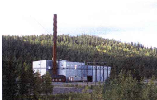
Bild. Värmeverket HVC Västlunda
