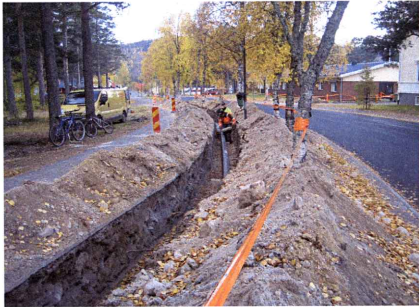
Utbyggnad av fjärrvärmenät Arvidsjaur 2007
