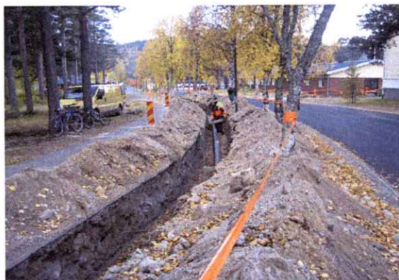
Bild. Fortsatt utbyggnad av fjärrvärme även 2011
